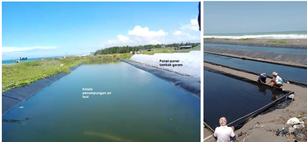
Gambar 6. Posisi laut, kolam penampungan, dan panel-panel tambak garam di Desa Patutrejo. Sumber foto sebelah kanan: https://dinppkp.purworejokab.go.id/alih-fungsi-lahan-tambak-udang-menjadi-tambak-garam-dilakukan-oleh-petani-garam )
